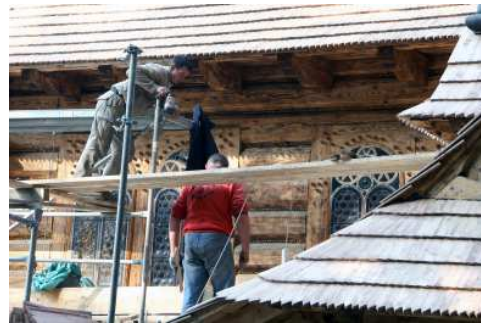
Fot. 66 Konserwacja ściany kapliczki
